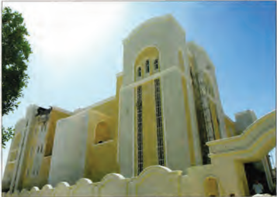
مبنى الكنيسة القبطية الجديد في منطقة حولي
